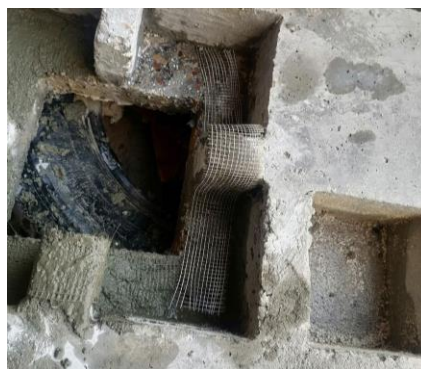
Fig.3 BTRM installation
